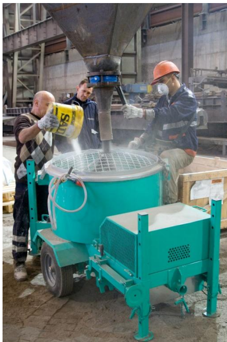
Figura 2.1. Mescolamento del tracciante BaSO_4 (bianco) con la massa refrattaria L-MgO in una betoniera prima della messa in opera dell'intonaco
