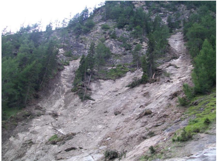
Figura 5: Area d'innesco situata nei pressi del Rio Avenes (Archivio ED30).
