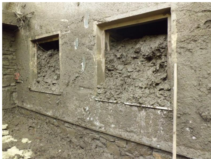
Figura 43: Particolare di un'abitazione posta poco sotto l'apice del conoide in corrispondenza dell'abitato di Avenes (Archivio ED30).
