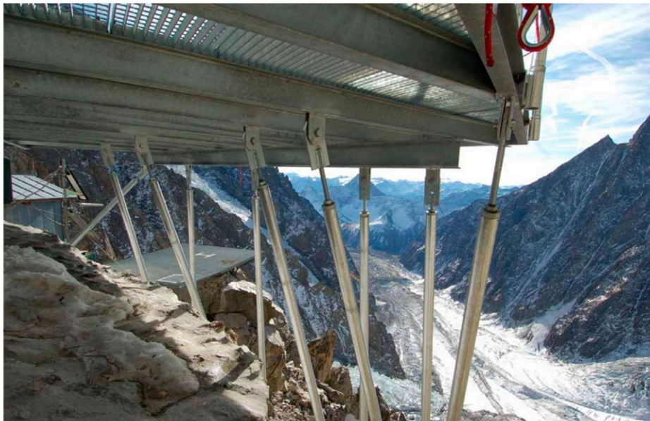
Figura 25: Dettaglio elementi di sostegno plateatico nel Rifugio Gonella
