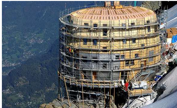
Figura 14: Immagine del Rifugio Gouter durante la fase di costruzione
