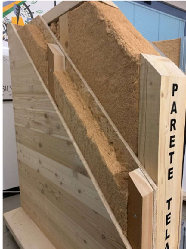
Figura 95: Spaccato di un elemento parete
