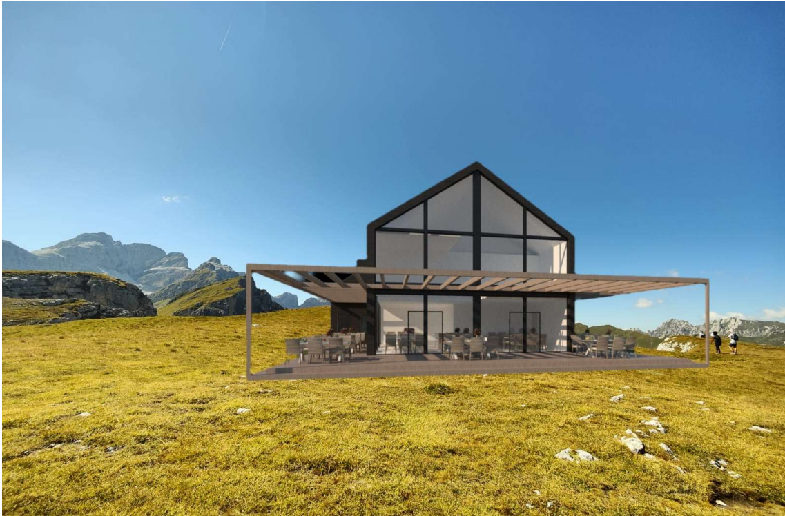
Figura 117: Rifugio Crëp das Dodesc, vista facciata Sud-Est
