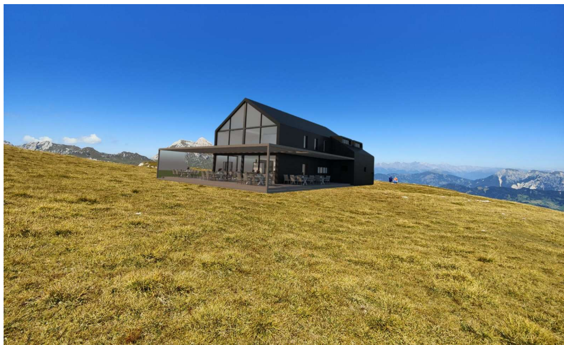
Figura 116: Rifugio Crëp das Dodesc, vista lato Est
