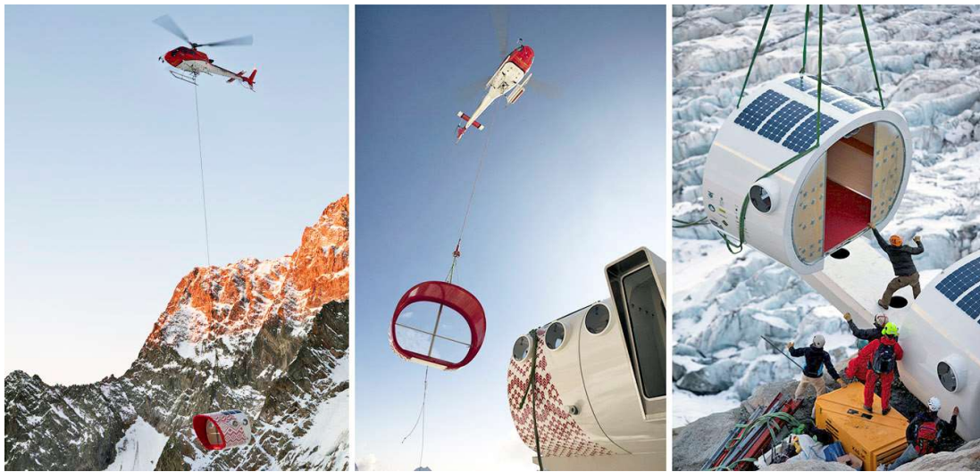
Figura 40: Assemblaggio moduli Capanna Gervasutti tramite elicottero
