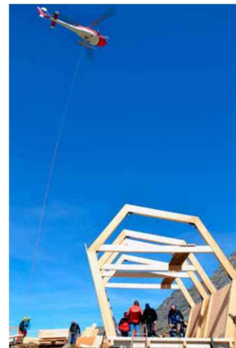
Figura 35: Assemblaggio del Bivacco Clapier con elicottero
