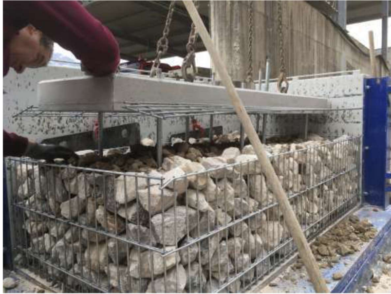
Figura 109: assemblaggio gabbione
