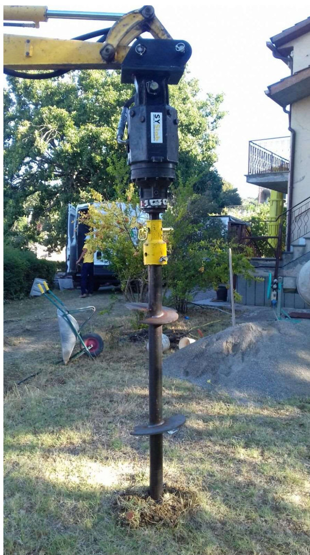
Figura 106: posa di pali trivellati a elica con macchine operatrici
