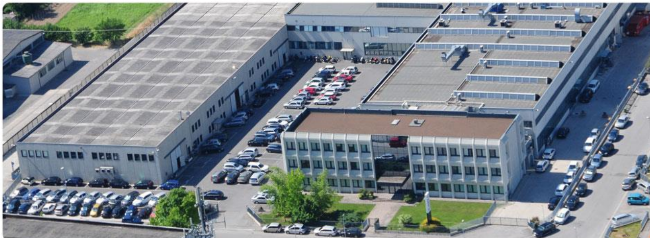
Figura 1.1 Sede di Brugine CAREL S.p.A.
