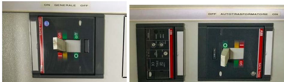
Figura 4.9: Interruttore: a sinistra generale, a destra autotrasformatore
