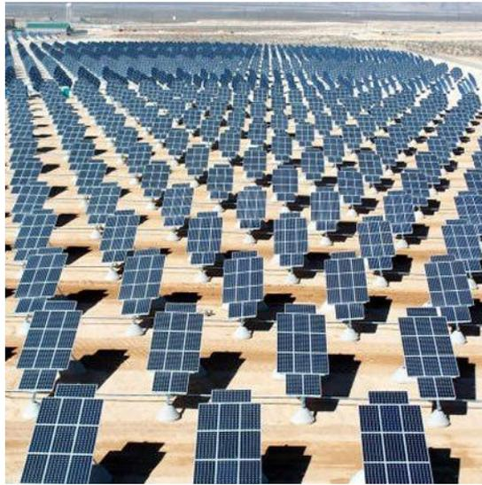
Le centrali basate su pannelli fotovoltaici convertono direttamente l'energia solare in corrente elettrica sfruttando l'effetto fotovoltaico. Senza azioni termodinamiche né chimiche il fotone stesso mette in circolo l'elettrone che trasporta l'energia. Non vi sono parti in movimento, né particolari manutenzioni da eseguire. Per la sua immediatezza, disponibilità e prevedibilità della radiazione solare, questa tecnologia è molto apprezzata dai tecnici che prevedono grandi potenziali di sviluppo.
