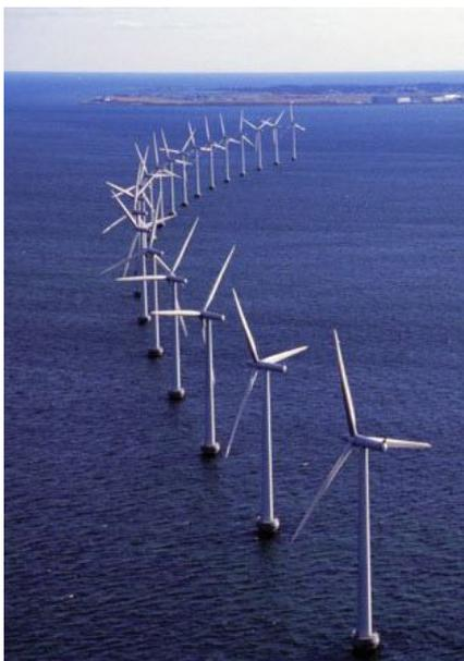
Le centrali eoliche sono centrali che sfruttano la velocità del vento per la produzione di energia elettrica. Il principio di funzionamento è abbastanza semplice, il modulo base di una centrale eolica è il generatore eolico. Questa apparecchiatura è composta da un'elica (o al limite una singola pala) collegata ad un albero alla quale è calettato il generatore di corrente.
