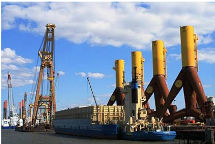
Figura 18. Stoccaggio delle strutture di fondazioni in porto
