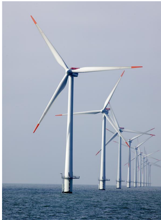
Figura 33. Aerogeneratore utilizzato ( H_{mazzo}=90\text{ m} ; D=126\text{ m} )
