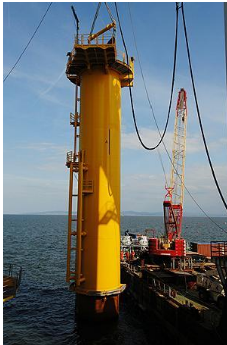
Figura 20. Sommità del sostegno
