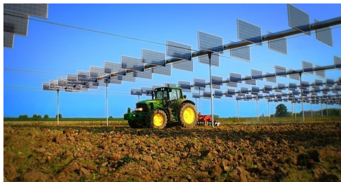
Figura 1.1. Impianto agrivoltaico (Fonte: euractiv.it)
