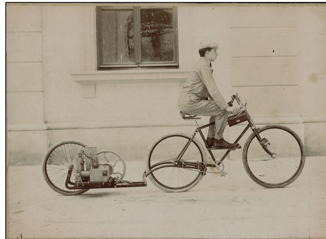
Fig. 13: Bicicletta a motore di Enrico Bernardi, monta un Motore Lauro raffreddato ad acqua (6)
