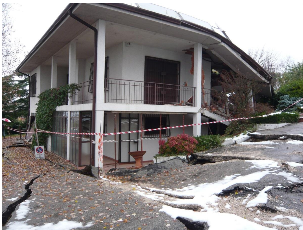
Figura 34 Abitazione distrutta dalla frana in Via Costa, Fara Vicentino
