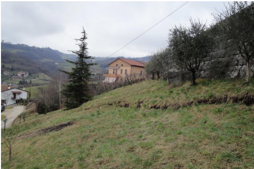
Figura 33 Foto del fenomeno franoso in via Fogliati
