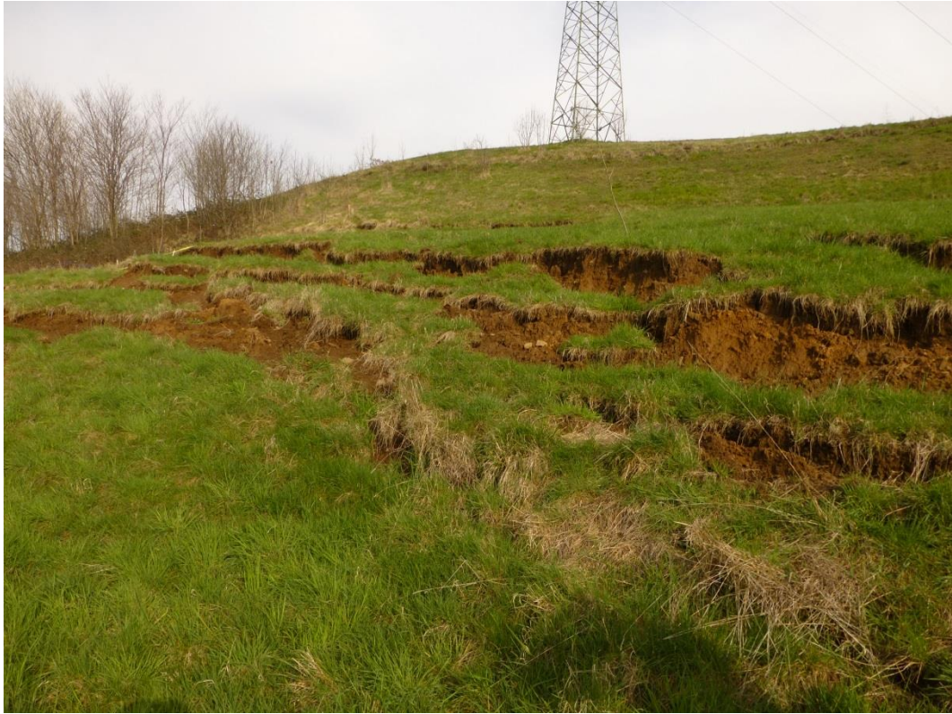
Figura 28 Rotture per tensione a Carrè in Via Valdaro
