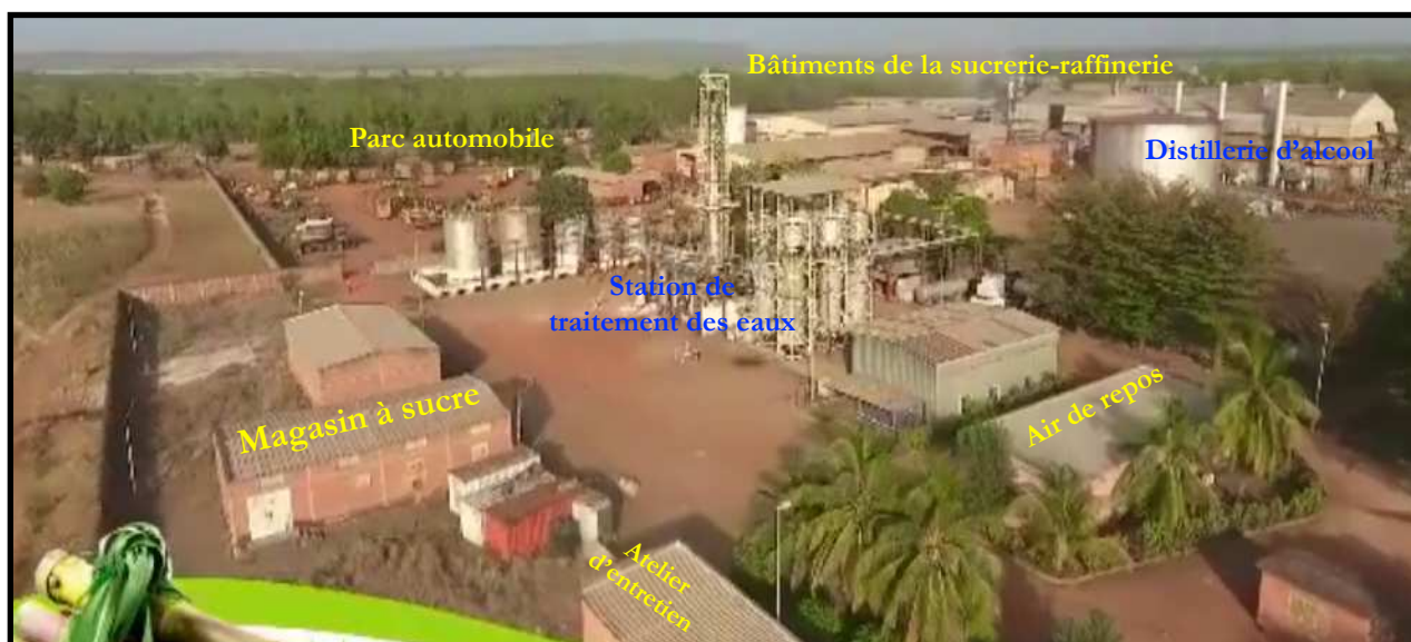
Figure 12 : Photographie panoramique de la sucrerie-raffinerie de la SN SOSUCO
