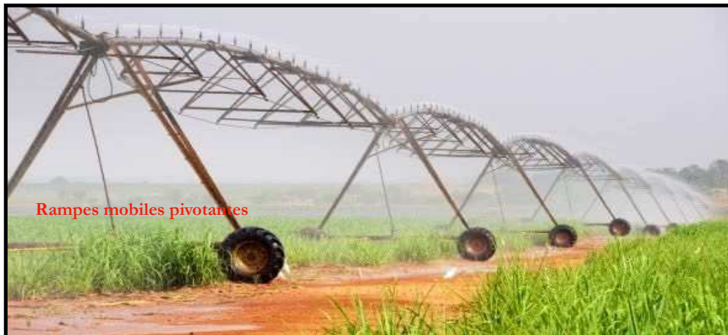
Figure 25 : Photographies de l'équipement hydraulique de la SN SOSUCO
