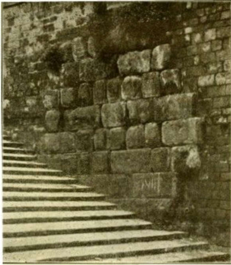
Fig 1: Muratura alla base del ponte del Duomo (da SCRATTOLI, I monumenti di Viterbo , Viterbo 1929, p. 9)
