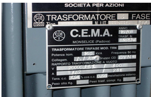
Illustrazione 8: Dati di targa del trasformatore TR1
