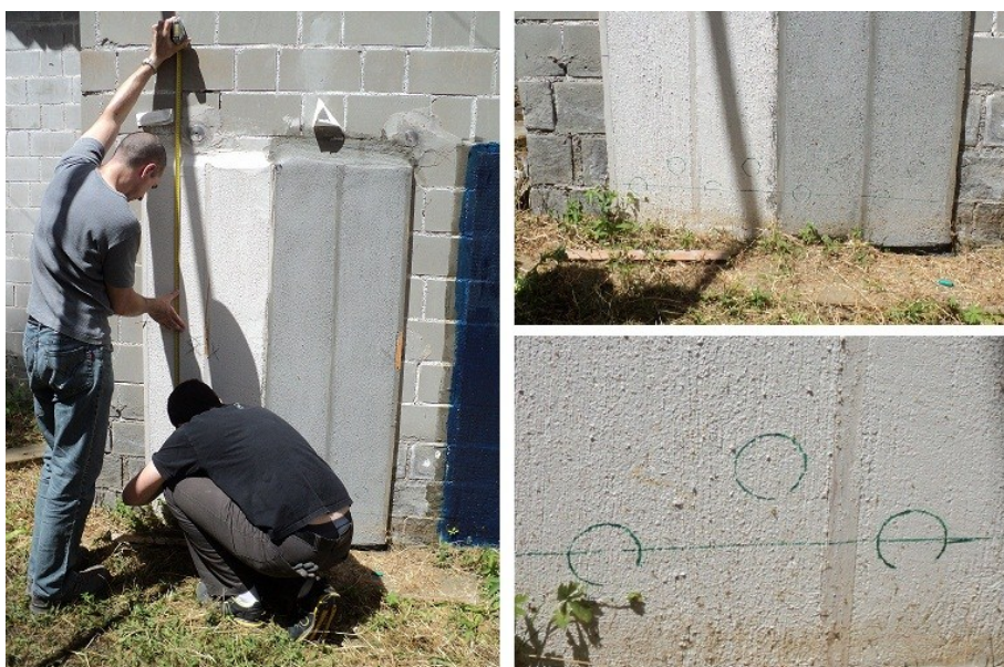
Figura 3.30: fasi di marcatura delle impronte dei dolly;
