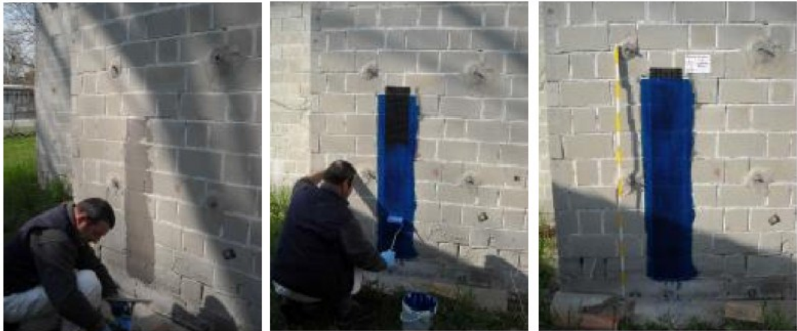
Figura 3.21: applicazione del composito a matrice epossidica MBrace Saturant Adesivo + MBrace High Strenght Carbon Fibres sul pannello A2 in pietra.
