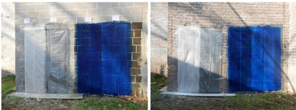
Figura 3.20: pannelli A4 in pietra e B4 in mattoni al termine della fase di applicazione dei materiali compositi.
