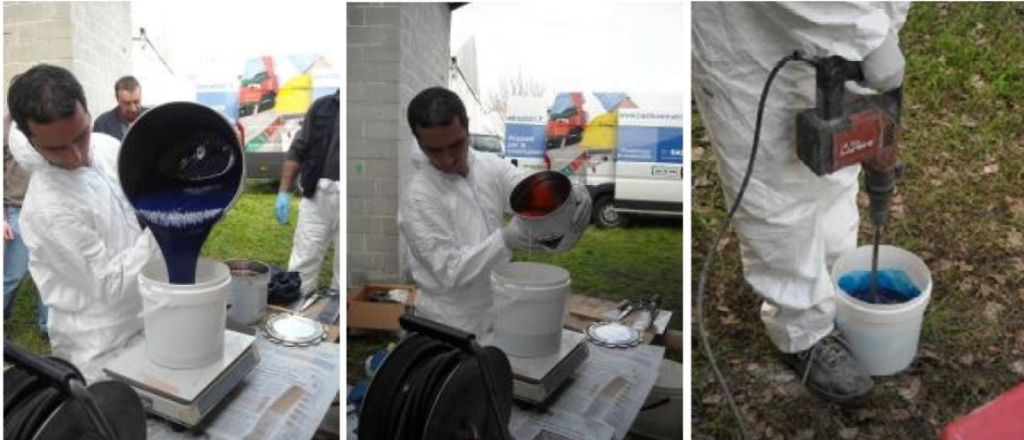
Figura 3.15: preparazione e miscelazione di MBrace Saturant Adesivo ;
