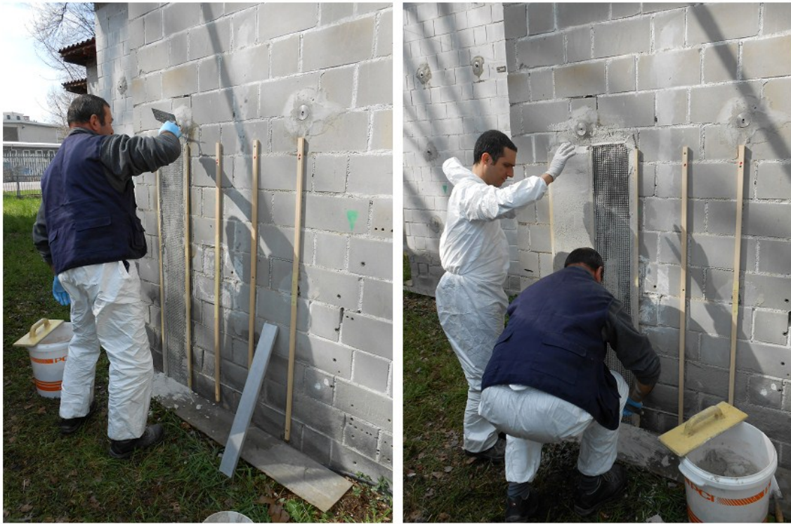
Figura 3.11: fasi di applicazione di ALBARIA STRUTTURA + MBrace Fibre Net CF 200B sul pannello A4 del modello in pietra.
