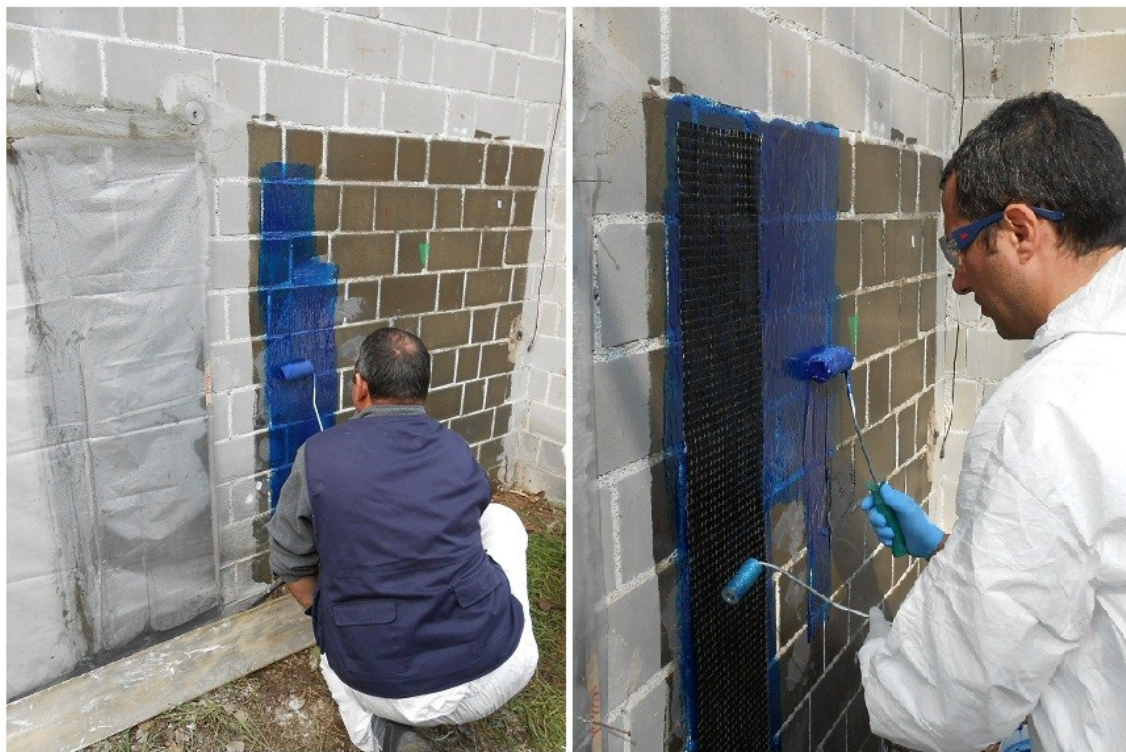
Figura 3.16: applicazione del composito a matrice epossidica MBrace Saturant Adesivo + MBrace High Strength Carbon Fibres sul pannello A4 in pietra.
