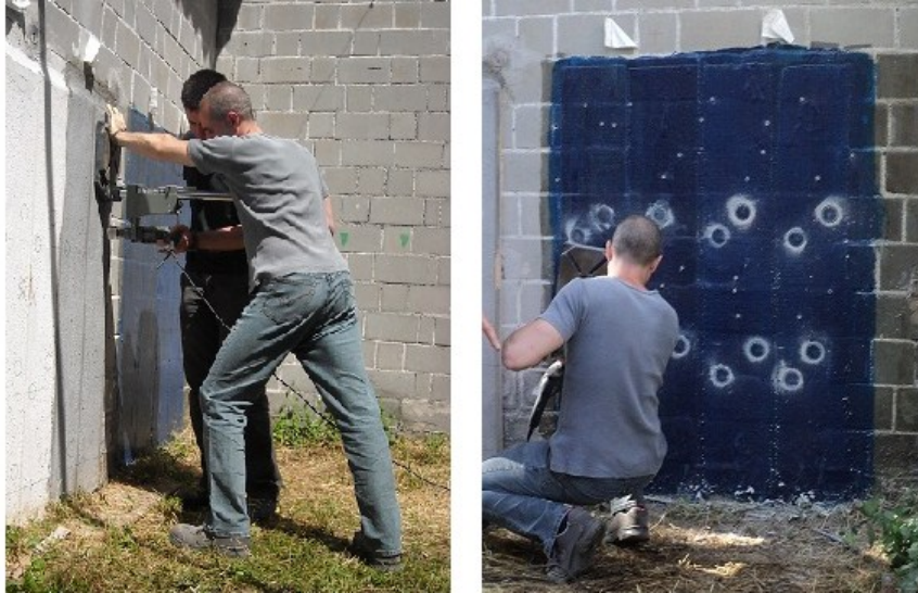
Figura 3.37: fasi di incisione mediante tazza diamantata applicata a trapano portatile;
