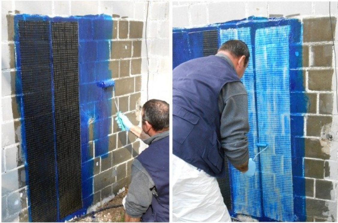
Figura 3.17 applicazione del composito a matrice epossidica MBrace Saturant Adesivo + MBrace Glass Fibres sul pannello A4 in pietra.
