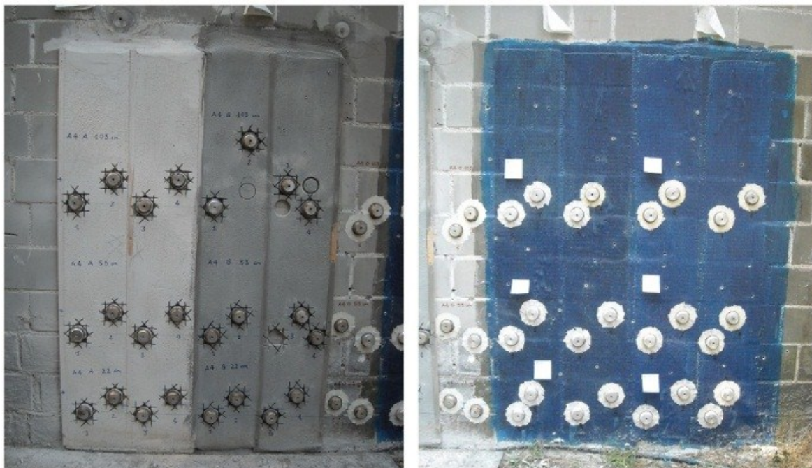
Figura 3.45: modulo A4 in pietra con i dolly incollati; a sinistra i dolly incollati sull'applicazione di ALBARIA STRUTTURA e EMACO R955M, a destra sull'applicazione di MBrace Saturant Adesivo con fibre di carbonio e con fibre di vetro;
