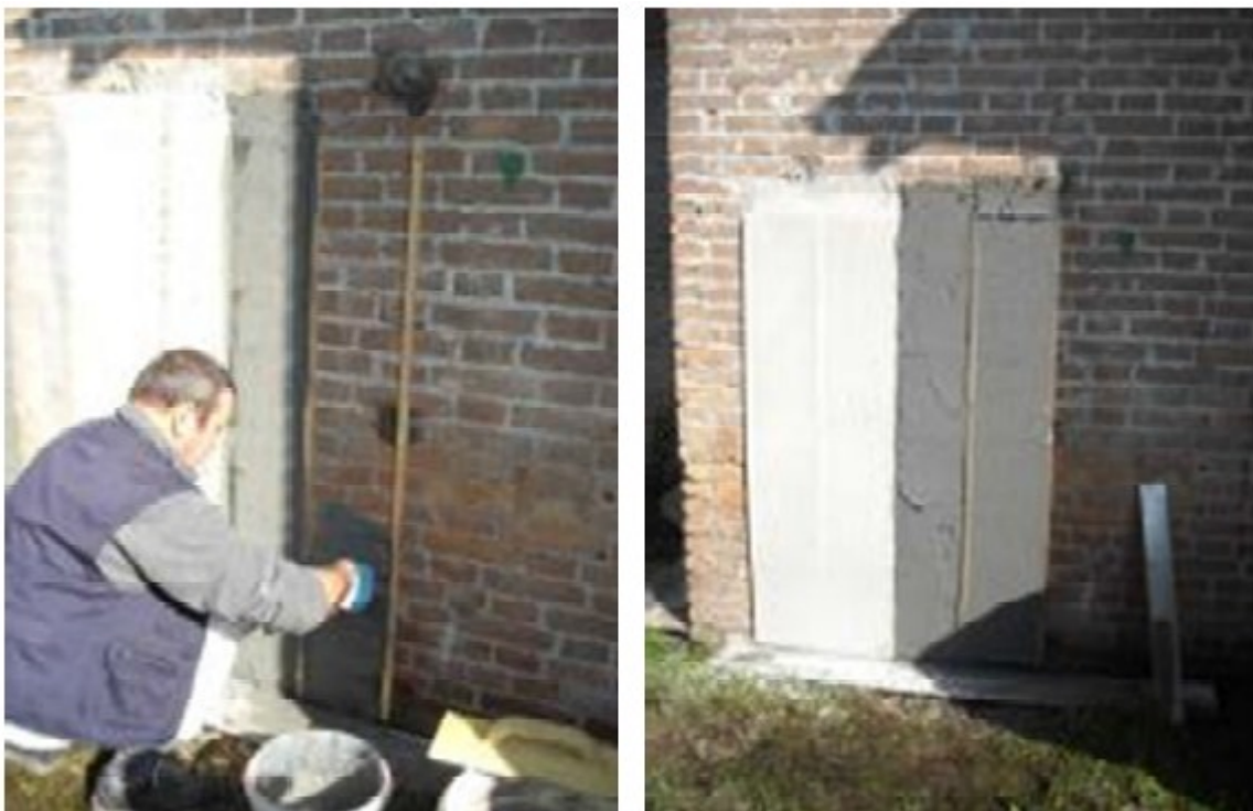
Figura 3.13: fasi di applicazione di EMACO R955M + MBrace Fibre Net CF 200B sul pannello B4 del modello in mattoni.
