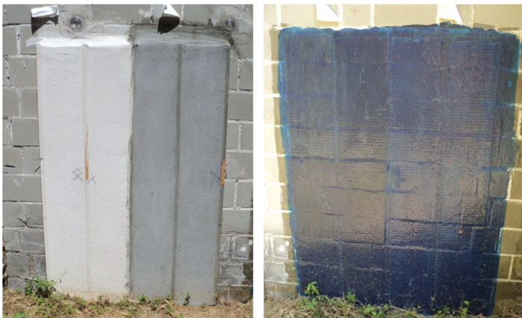
Figura 3.25: modulo A4 in pietra dopo l'applicazione dei materiali compositi; a sinistra l'applicazione di ALBARIA STRUTTURA e EMACO R955M , a destra l'applicazione di MBrace Saturant Adesivo con fibre di carbonio e con fibre di vetro ;
