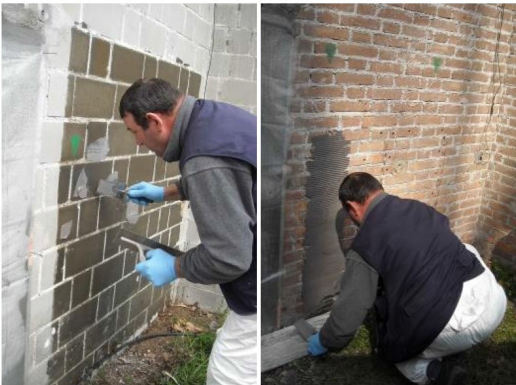
Figura 3.14: a destra la stuccatura dei piccoli difetti sul pannello A4 in pietra; a sinistra la preparazione del sottofondo per l'applicazione della resina sul pannello B4 in mattoni;
