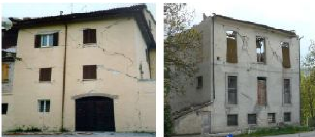
Fig. 5.8 Meccanismi di taglio.
