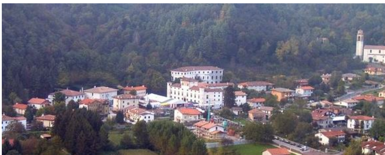
Fig. 9.6 Veduta d'insieme Palazzo Polcenigo - Cavasso Nuovo.
