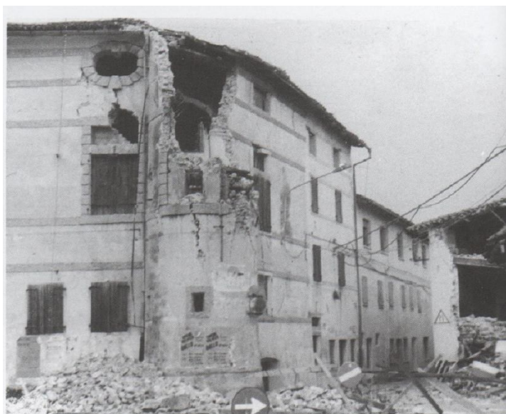
Fig. 9.5 Il "Palazat" dopo il settembre 1976, particolare torre sud.
