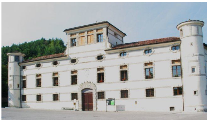
Fig. 9.7 Palazzo Polcenigo facciata Ovest, ristrutturato a seguito del terremoto del 1976
