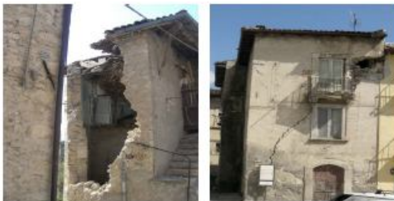
Fig. 5.7 Esempi di flessione orizzontale.
