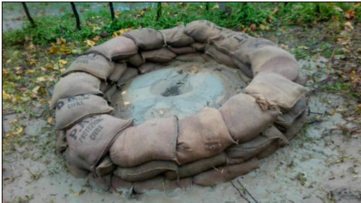
Figura 1.2: Esempio di intervento sui fontanazzi nella zona a Nord di San Michele 31/10/2023, Pinter (2024)
