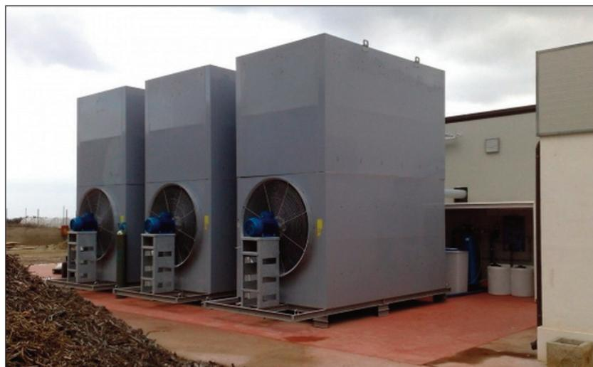
*Figura 5.12 - Torri evaporative di un impianto ORC*
