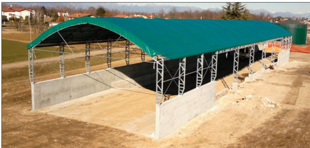
*Figura 5.20 - Copertura prefabbricata utile per lo stoccaggio di sostanze legnose*
