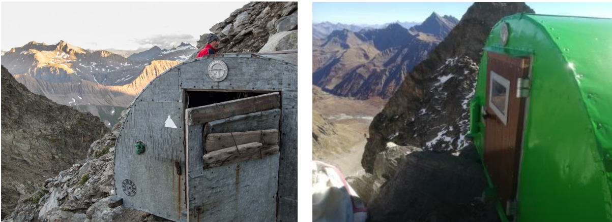
Figura 12 bivacco Hess prima del 2016 e dopo l'intervento del 2016
