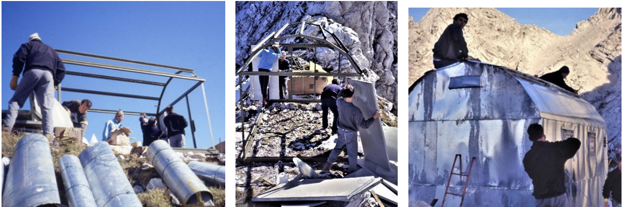
Figura 35 Le fasi del montaggio in situ
