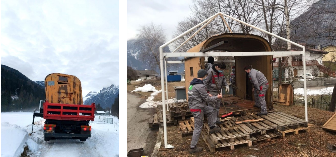
Figura 110 Restauro del bivacco Fanton da parte dell'Enaip di Longarone
