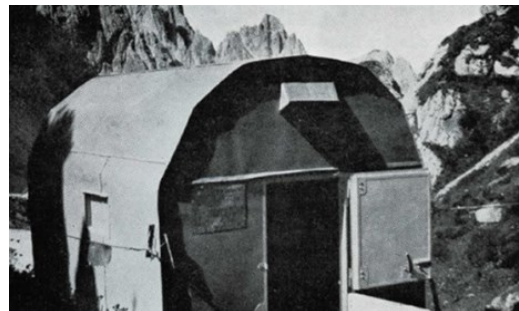
Figura 27 copertura voltata modello "Fondazione Berti" del bivacco Piovan 1969
