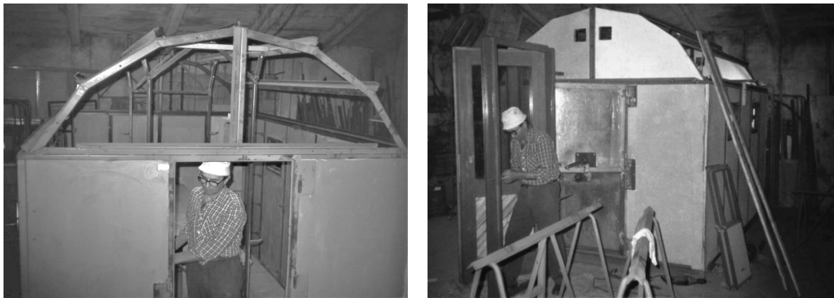
Figura 34 Le fasi della prefabbricazione nella “fabbrica dei bivacchi”
