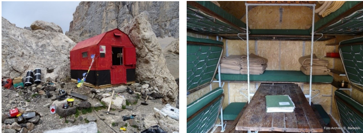
Figura 111 Ristrutturazione bivacco Dal Bianco sulla Marmolada (2017)
