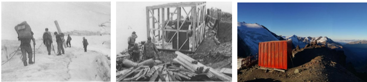
Figura 83 Il montaggio del bivacco Colombo effettuato con l’ausilio di 10 muli e poi 40 alpini della Brigata Orobica e oggi.
