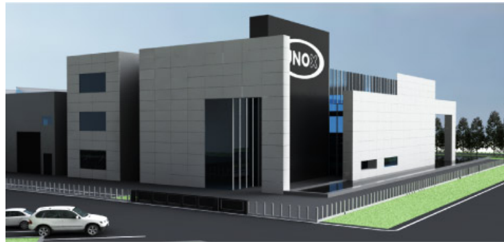
Figura 1.2: La nuova sede di UNOX, che sarà pronta a Giugno 2011.
