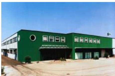
Figura 3.8 Nuovo stabilimento a Veggiano (PD), 1998
