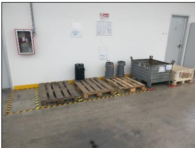
Figura 4.20 Corretto layout per accessibilità ad idrante
