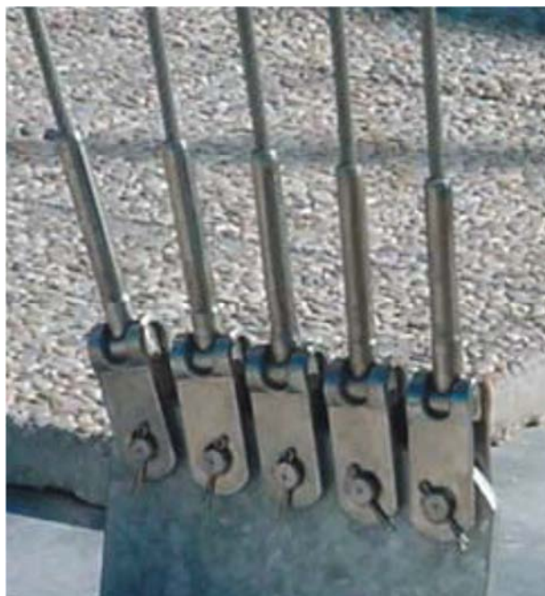
Figura 45: Applicazione della forcella snodata in una struttura
