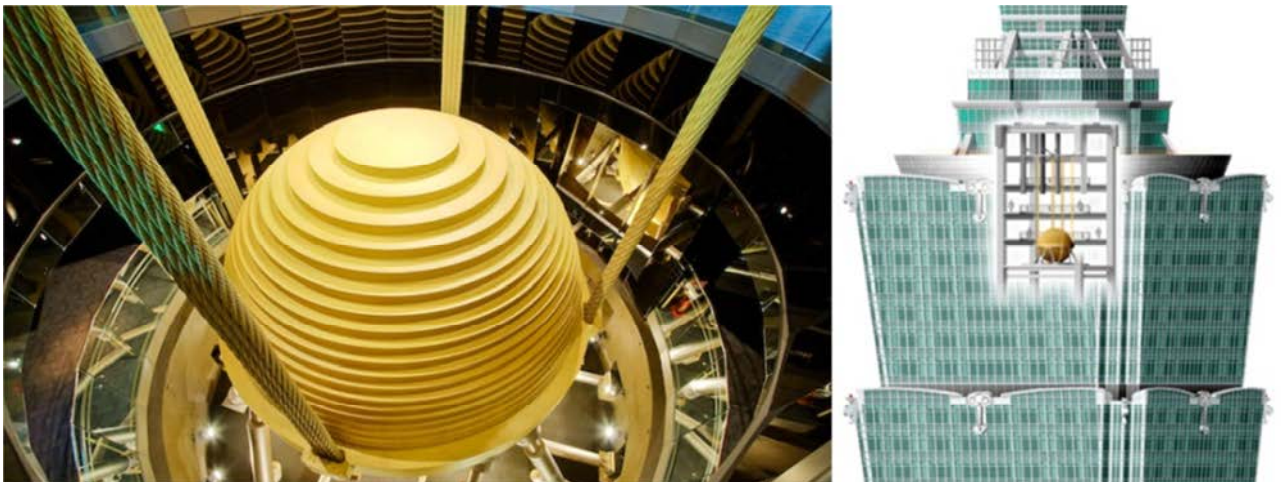
Figura 10: Esempio noto di PTMD di 660 tonnellate per l'edificio Taipei 101
