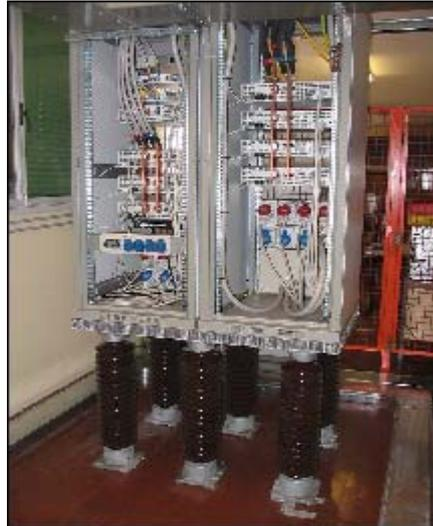
Figura 2.20: Vista dei *rack* contenenti tutti i dispositivi aventi un potenziale di 30kV .
