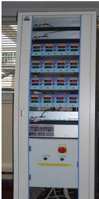
Figura 2.21: Vista del *rack* contenente i sistemi di controllo e di alimentazione per il deflettore, il tripletto di quadrupoli , l'alimentatore ad alta tensione ed il blocco estrattore.
