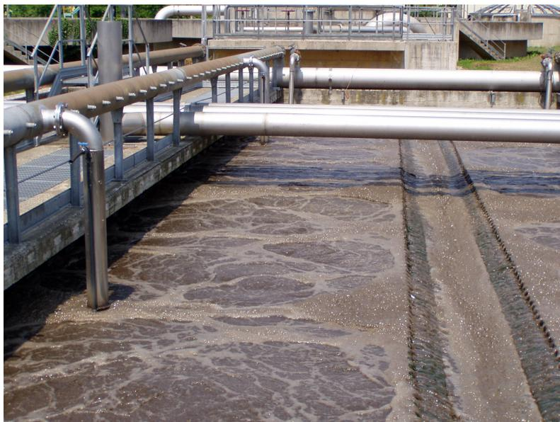
**Figura 1.2:** Particolare di una vasca di ossidazione e della canaletta di scolo
