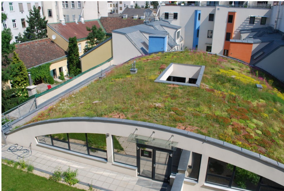
Figura 11: Esempio di copertura verde (estensiva) in un quartiere residenziale di Vienna, Austria. (Fonte: https://efb-greenroof.eu/work/extensive-green-roof-austria/ )
