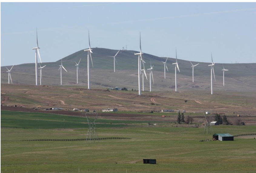
Figura 6: Impianto eolico on-shore.
