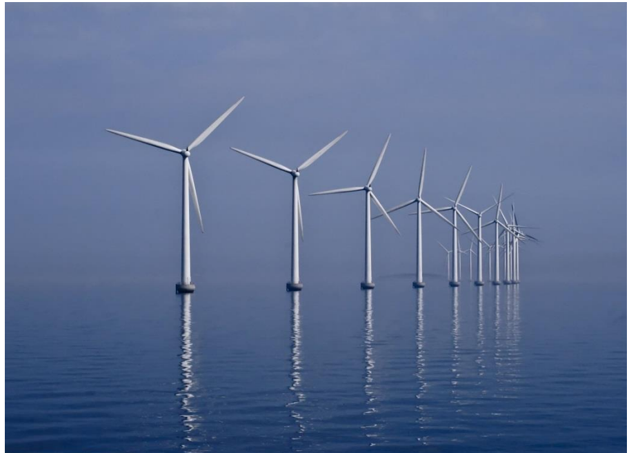
Figura 8: Middelgrunden, impianto eolico da 40 MW nello stretto di Oresund al largo di Copenaghen.
