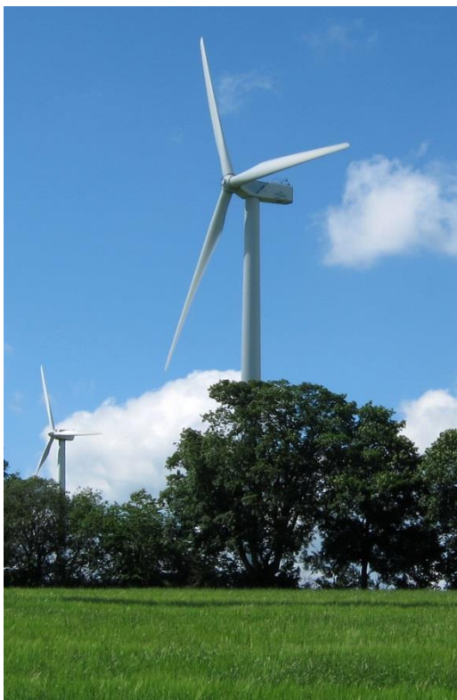
Figura 11: Generatore ad asse orizzontale tripala composto da torre, navicella, rotore e pale
