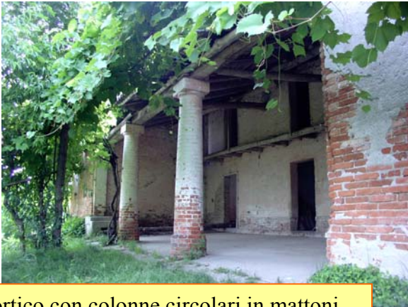
Portico con colonne circolari in mattoni cotti.
