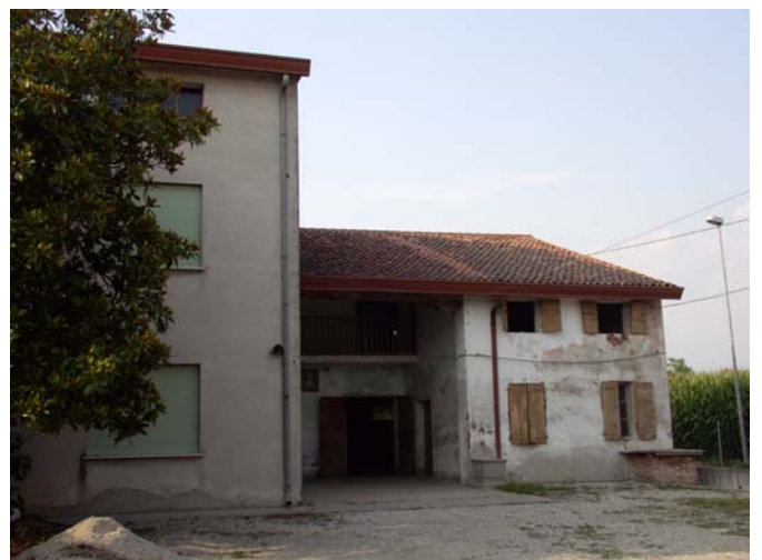
Foto 5. Casa Pettenuzzo, modificata nel 1964 con la costruzione di un nuovo corpo abitativo, con rustico incorporato.
