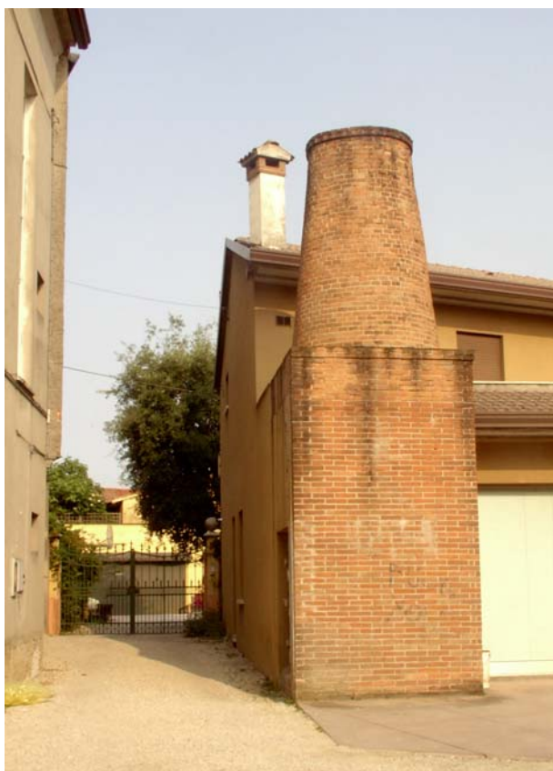
Foto 7. Il camino della filanda collocata in centro.
