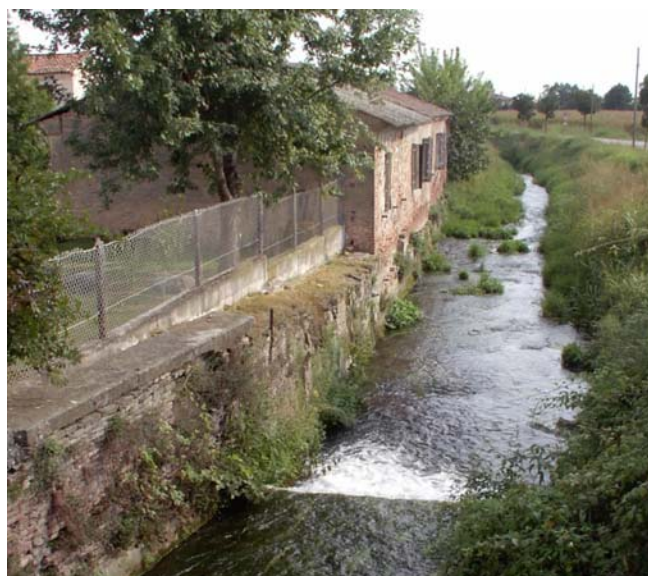
Foto 6. Il secondo gradino che serviva ad imprimere ulteriore forza all'acqua diretta alla ruota motrice del maglio.
