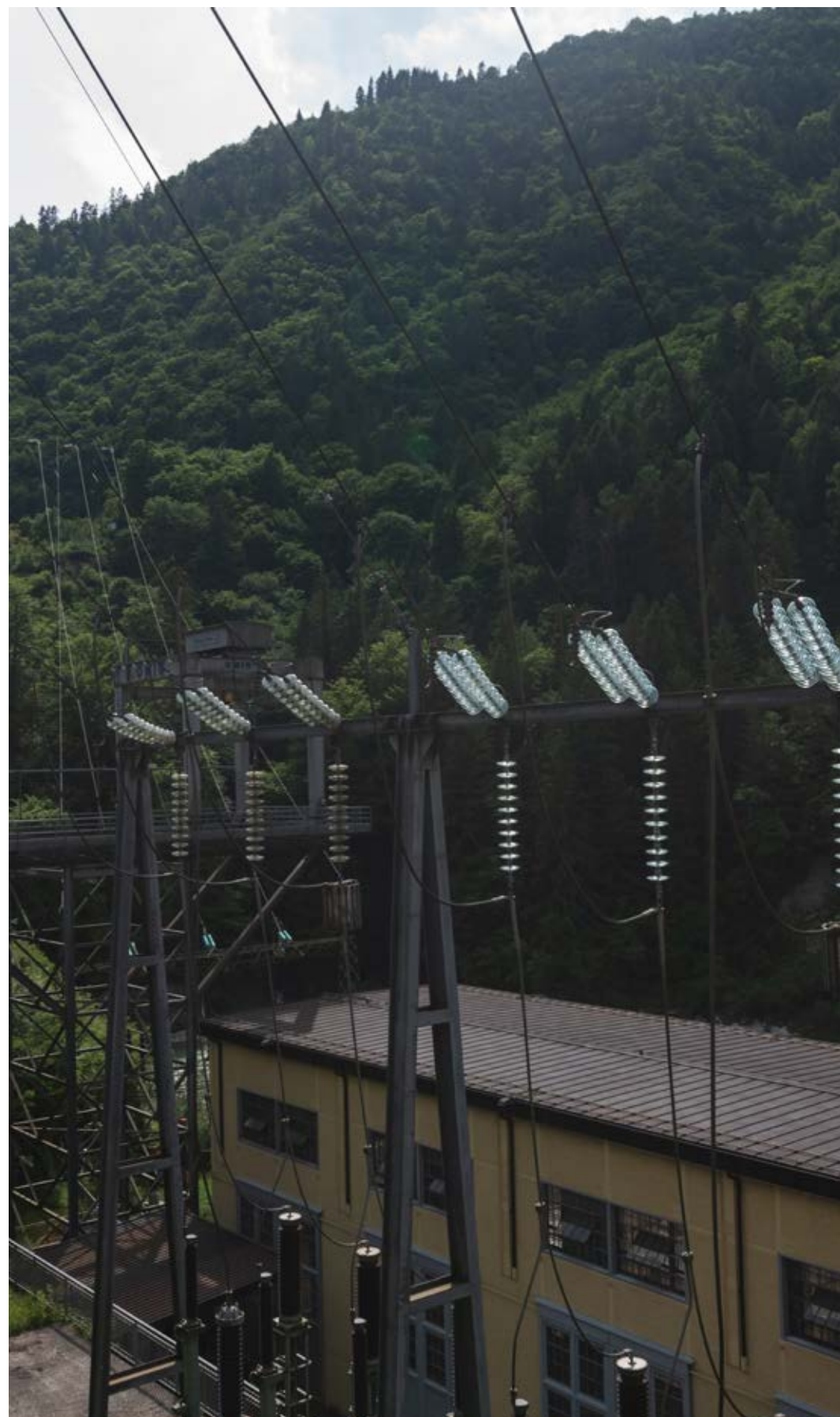
Centrale idroelettrica delle Moline, Sovramonte, 2024
