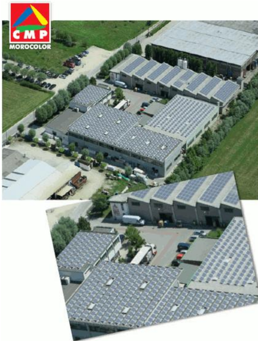
Figura 2.1. Impianto fotovoltaico di cui è dotata la Morocolor Italia S.p.A. (Fonte www.morocolor.it )
