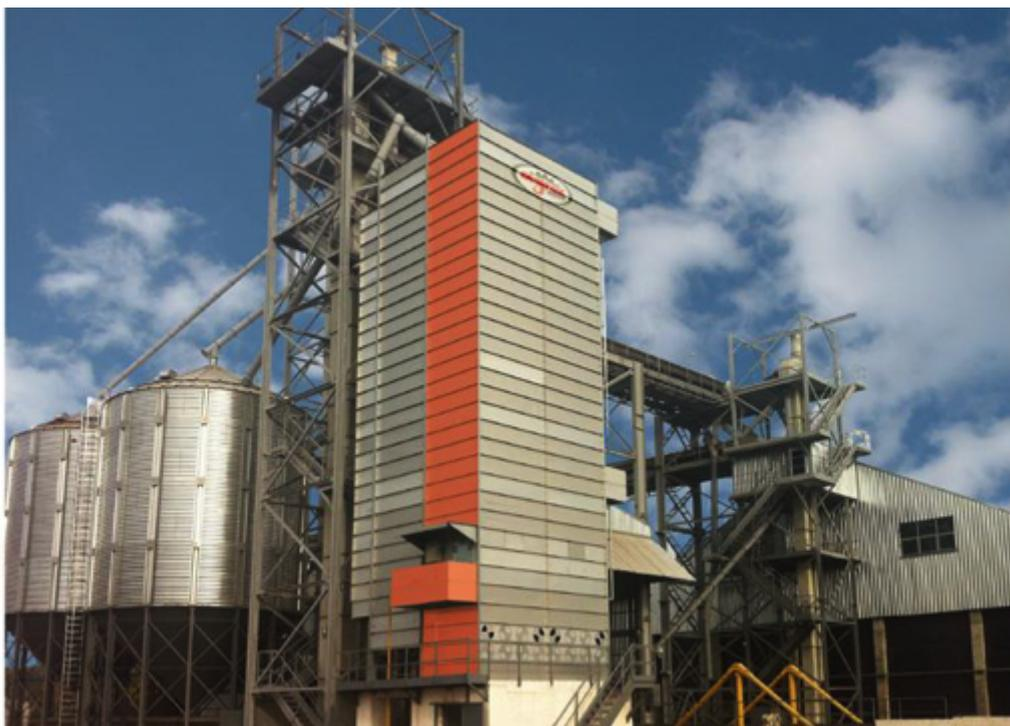
*Fig. Un essiccatoio a ciclo continuo da 12 a 48 ton/ora (produzione grano da 19% a 14% d'umidità)*
