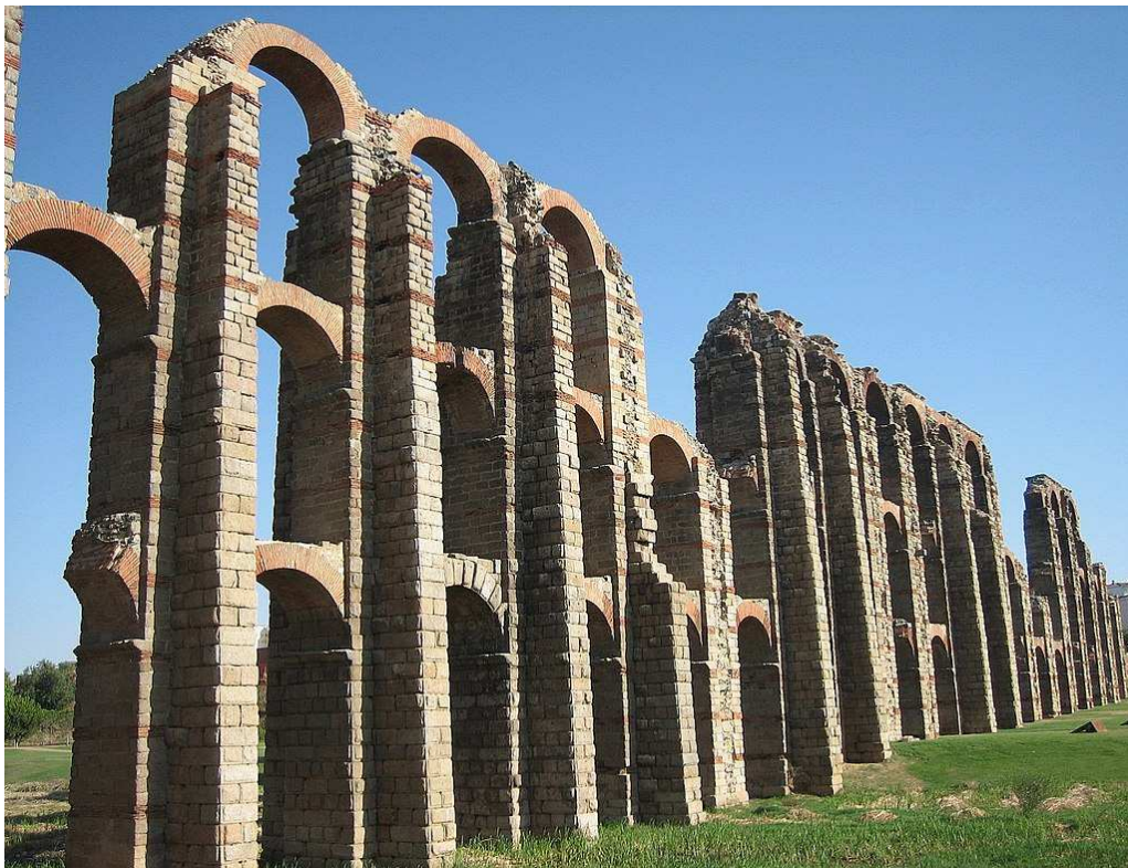
21. Mérida, Acquedotto dei Miracoli.
