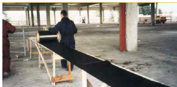
Fig. 2.7 – Preparazione del tessuto all'impregnazione, metodo wet lay up. [12]
