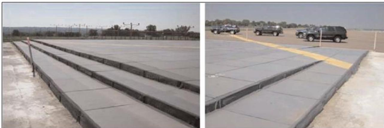
*Figura 1.1 Sistema EMAS al termine di una pista aeroportuale [1]*
