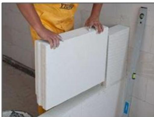
*Figura 1.2 Blocco di calcestruzzo cellulare in edilizia [4]*
