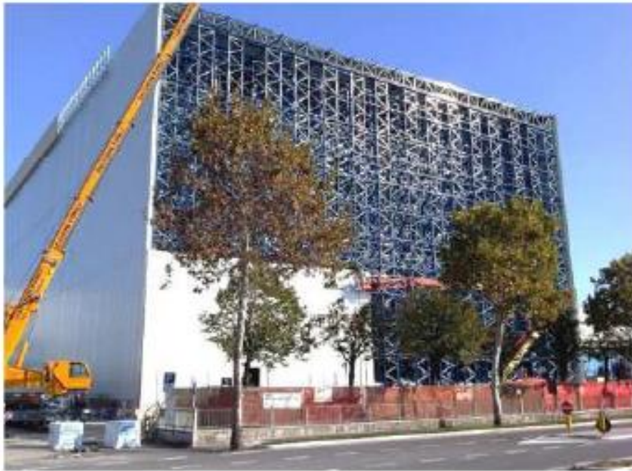
Figura 2.13 Esempio di magazzino autoportante [5]
