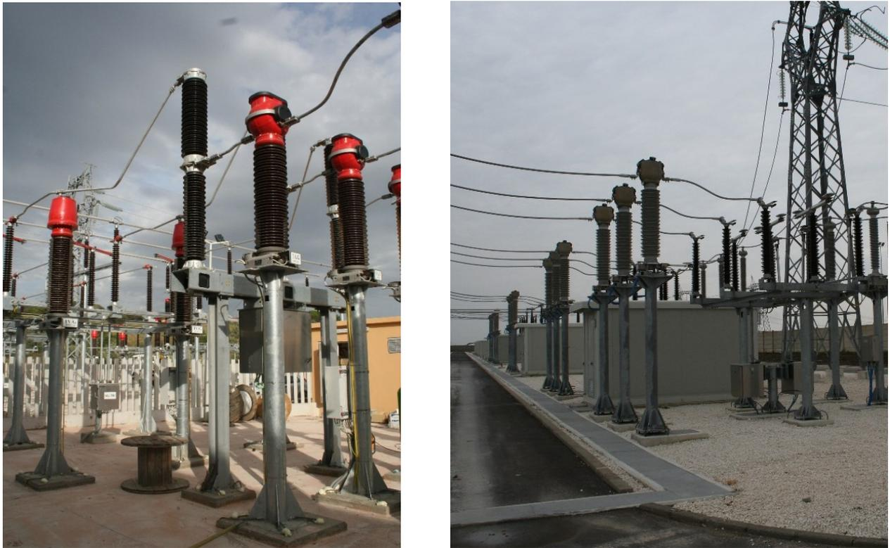
Figura 1-6 Foto di alcune installazioni di trasformatori di corrente per applicazioni AT
