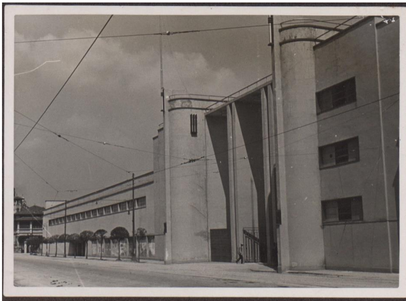
Fig. 2. Fiera Campionaria di Padova - Ingresso su Via Nicolò Tommaseo – 1935. 45
