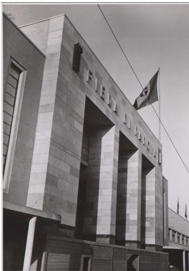
Fig. 3. Fiera Campionaria di Padova - Nuovo ingresso su Via Nicolò Tommaseo – 1936. 46
