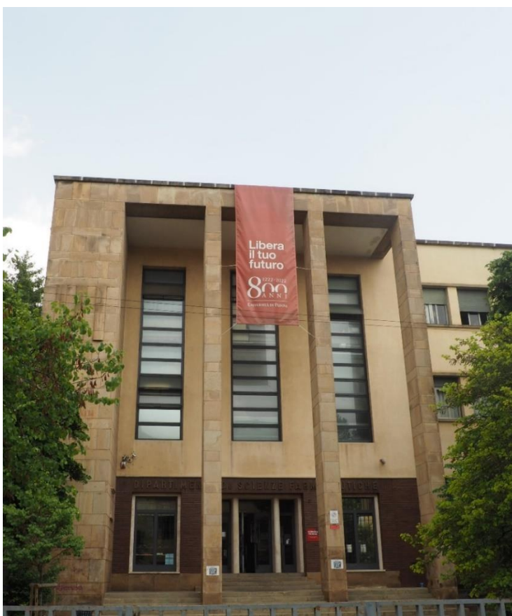
Fig. 6. Facciata edificio Facoltà Scienze Farmaceutiche oggi (2022).
