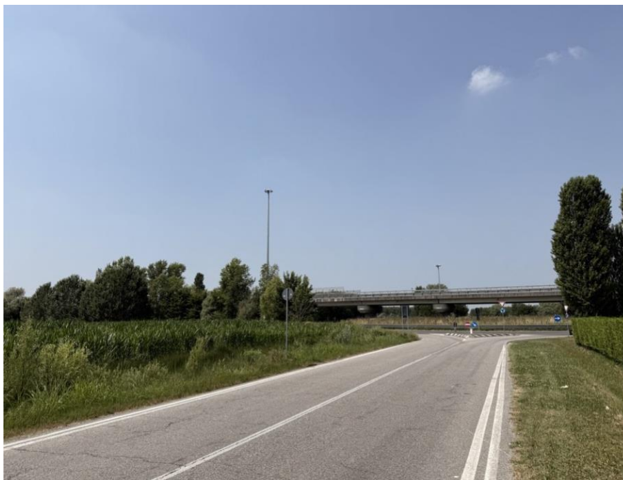
Figura 17. Cavalcavia della SR 308 e relative infrastrutture di collegamento. L'opera viaria rappresenta un elemento di forte impatto percettivo che altera la continuità del paesaggio agrario e interferisce con la riconoscibilità della trama territoriale storica. (Fonte: raccolta fotografica elaborata dall'Autore).
