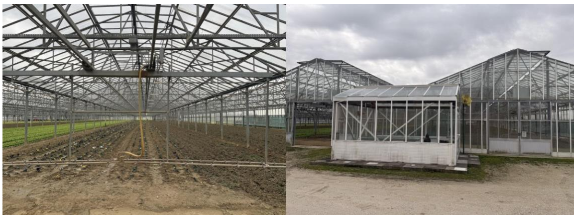
Figure 22 - 23. Raccolta fotografica dell'Autore delle serre presso la prima sede dell'azienda. L'area dei 4 ha, il nucleo originario dell'azienda.
