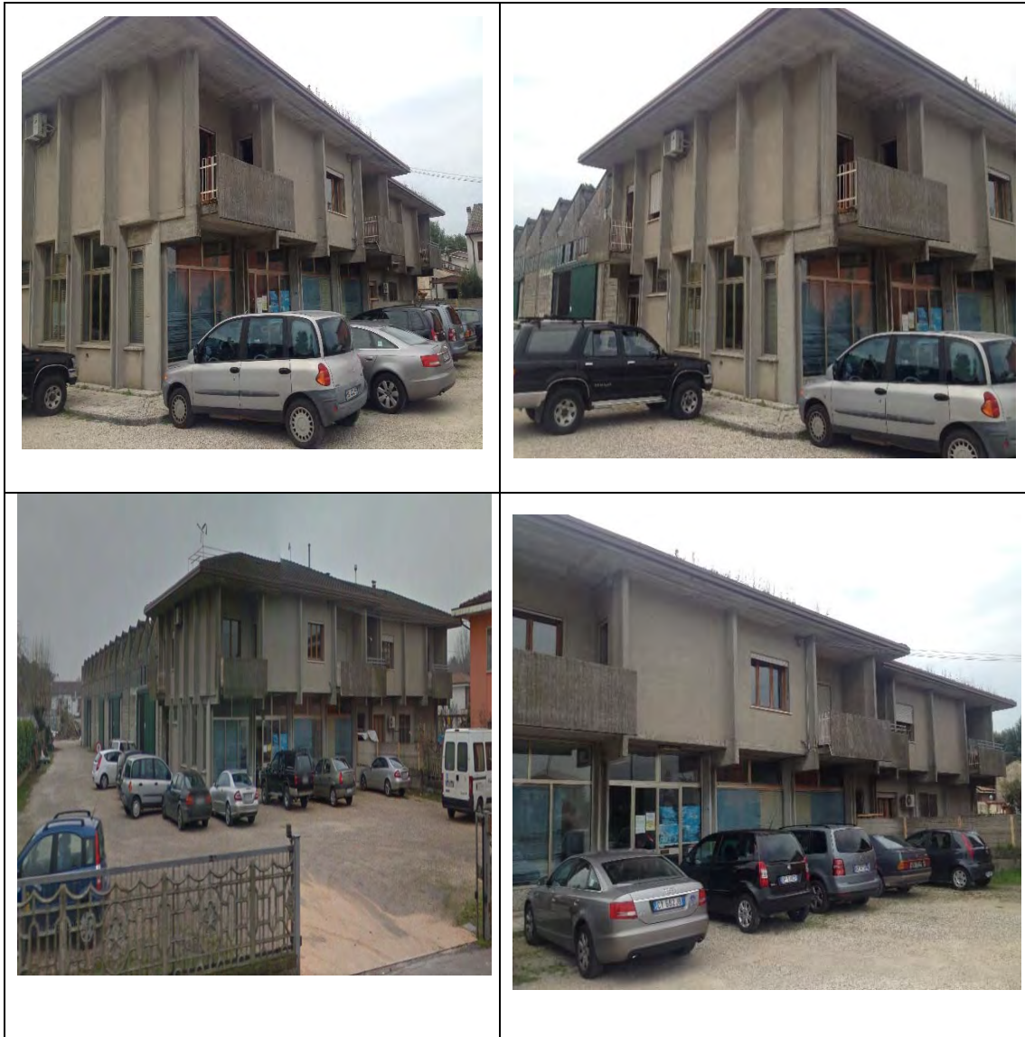
Figura 2.1: stato attuale dell'edificio, vista esterna.
