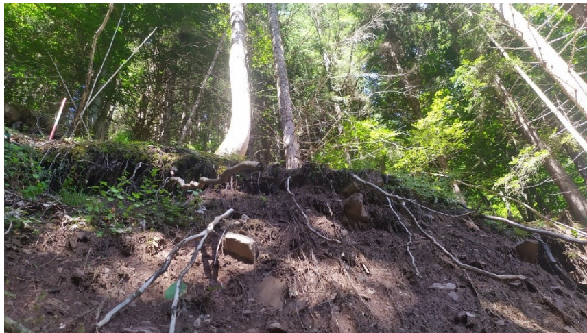
Figura 2: Radici laterali in prossimità della scarpata di frana, in seguito all'innesco.
