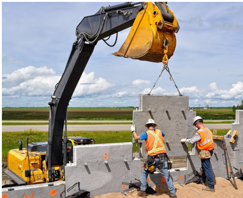
Figura 8: Escavatore utilizzato per il sollevamento di un elemento prefabbricato
