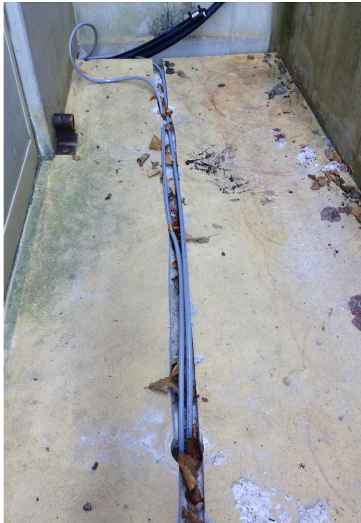
Figura 7.3.1. Sonde testate, poste all'esterno del capannone dell'azienda
