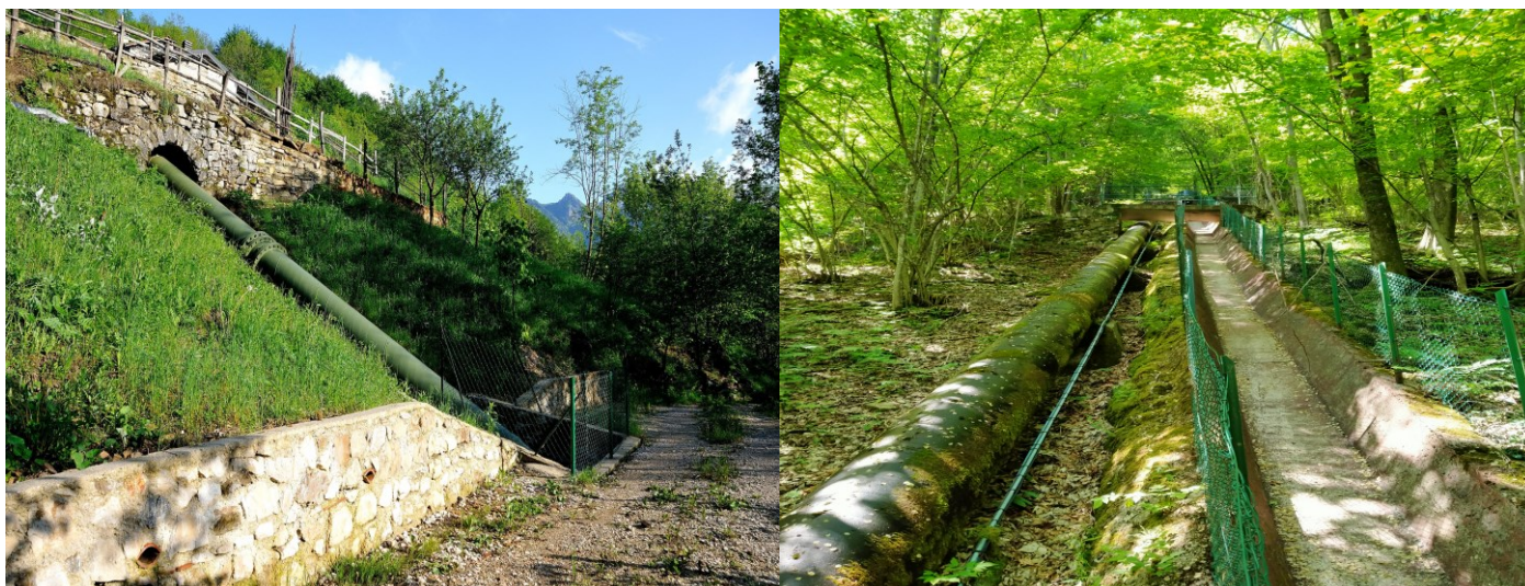
Figura 1 – A sinistra, dalla centrale Richellere parte la condotta che arriva sino alla centrale Marzotto. A destra la stessa condotta divide il bosco di acero-frassineto poco distante dalle aree di saggio.
