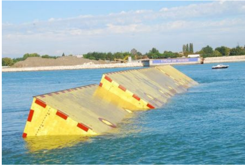
Figura 2.2 - Paratoie emerse durante la fase di collaudo
