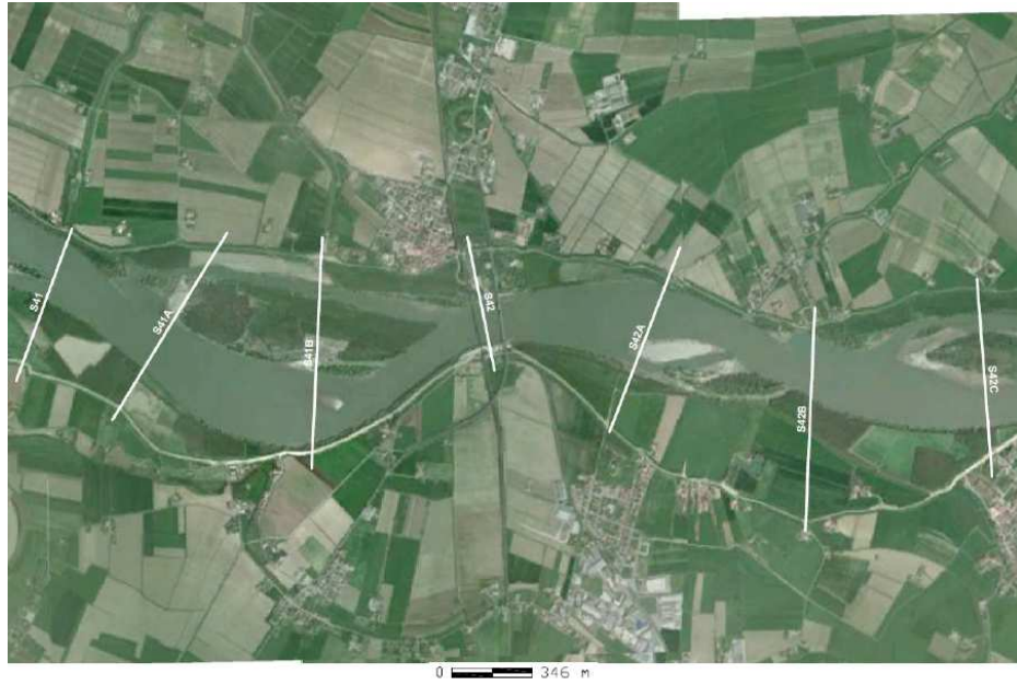
Figura A.2: Particolare del tratto del fiume Po qui analizzato: dalla sezione 41 alla sezione 42 C.
