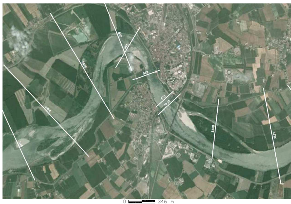
Figura A.8: Particolare del tratto del fiume Po qui analizzato: dalla sezione 49 alla sezione 53 C.
