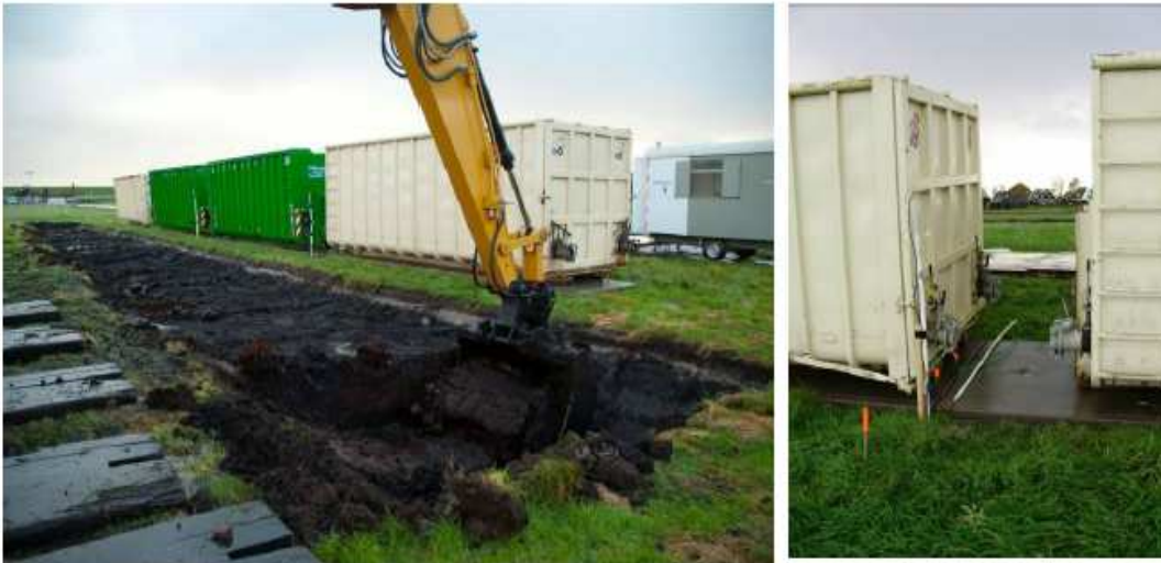
Figura 4.10. (a) Fila di container e inizio dello scavo e (b) attrezzatura di monitoraggio.
