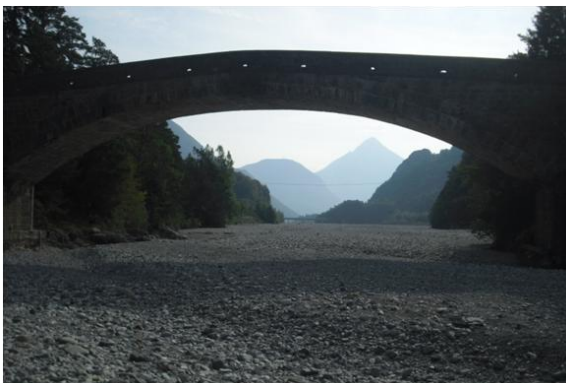
Fig. 30: il ponte presso col di Zuca, senza pile in alveo, permette il transito durante le piene senza il rischio di occlusioni
