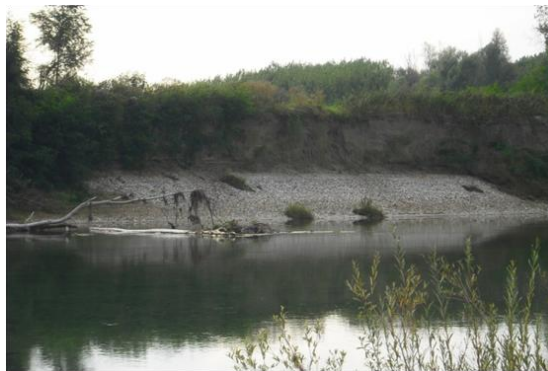
Fig. 45: sponda composta costituita da una base di ghiaie sovrastata da un ingente spessore di limi e argille
