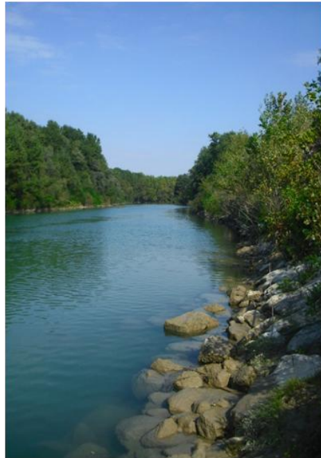
Fig. 47: scogliera realizzata a difesa del retrostante taglio di meandro
