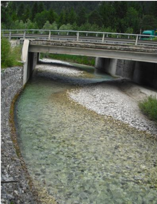
Fig. 53: ponte dell'autostrada A23 sul fiume, classificato come ponte di tipo 1
