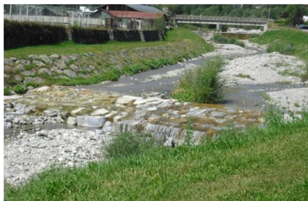
Fig. 23: parte intermedia del tratto, fortemente modificata dall'attività umana, che rinforzando le sponde ha ristretto l'alveo e realizzato ponti con luci ridotte
