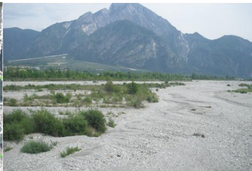
Fig. 32: panoramica del tratto visto dal ponte di Tolmezzo che evidenzia la larghezza del tratto e, in lontananza, le difese spondali lungo la sponda sinistra
