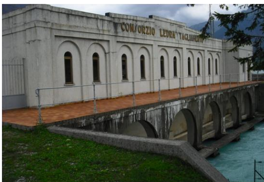
Fig. 36: chiusa che controlla la quantità di acqua derivata per il funzionamento della centrale di Pineda
