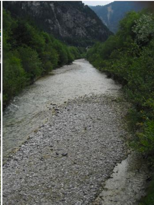
Fig. 54: tratto rettificato dell'alveo in località Ugovizza, le difese spondali sono nascoste nella vegetazione riparia
