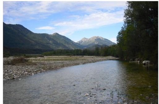
Fig. 34: panoramica del tratto presso Amaro; sulla destra si intravedono le difese spondali usurate
