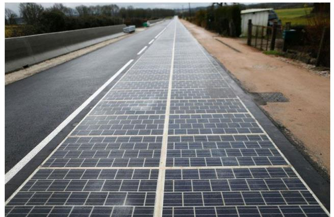
Esempi di strada fotovoltaica utilizzando pannelli solari
