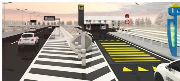
Le due immagini sopra riportate chiariscono meglio il concetto analizzato precedentemente: nella figura di sinistra si può osservare la presenza di un dosso cui sopra è stata installata una “pedana rallentatrice” che permette, attraverso il rallentamento dei veicoli, di produrre energia elettrica. Il principio di funzionamento è il medesimo anche nella seconda figura dove non è però presente il dosso (caso tipico di sede autostradale).
