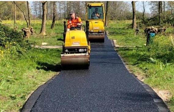
Esempio di piste ciclabili in Olanda realizzate mediante l'impiego di lignina.
