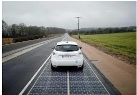
Altri esempi di pavimentazioni stradali con l’impiego dei pannelli solari.
