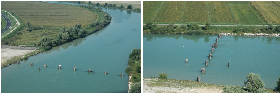
(a) Vista da nord-est
