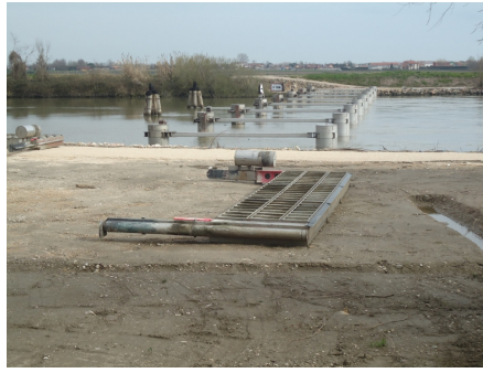
Figura 3.4: Paratoia dello sbarramento, rimossa per manutenzione
