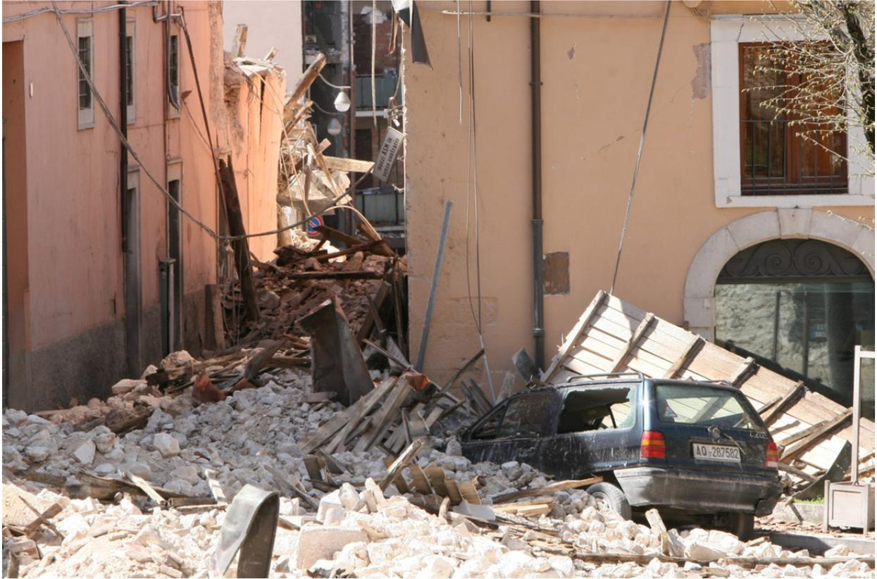
*Figura 6 Strada resa completamente inutilizzabile dal sisma dell'Aquila (aprile 2009)*
