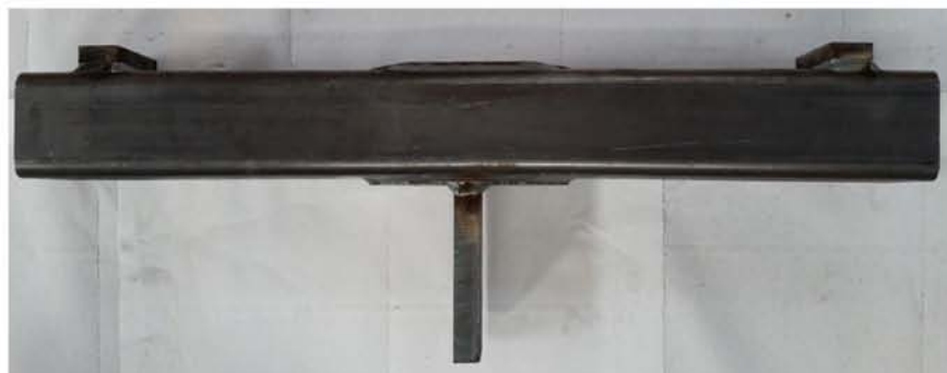
Vista laterale a rottura
