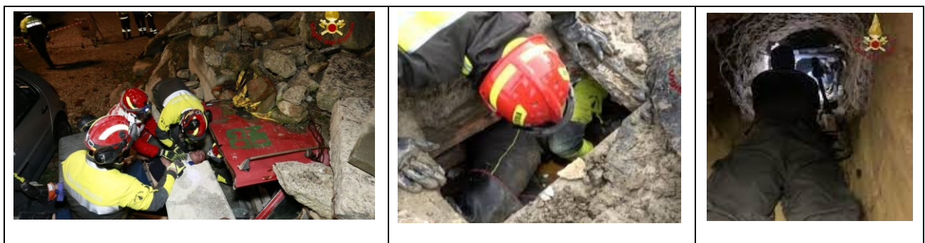
Figura 3.2. Esempio di interventi gravosi in ambienti angusti (www.vigilidelfuoco.it).
